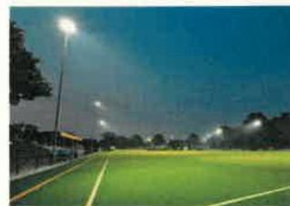
Bei Flutlichtanlagen für den Bundesligabetrieb oder für internationale Wettkämpfe sind auch Flutlichtanlagen mit 500 Lux und mehr problemlos umsetzbar. Hierbei werden durch eine bedarfsgerechte Lichtsteuerung Einsparungen von bis zu 80 % erzielt.
